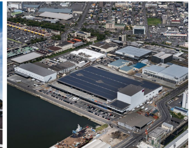
賃貸物件の屋上を活用したメガソーラー発電所、発電した電気は全量売電している
