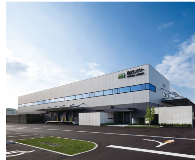
2021年12月より賃貸を開始した集約型クリーニング工場。建物はテナントの要望に基づき、DM三井製糖ホールディングスにて建築
