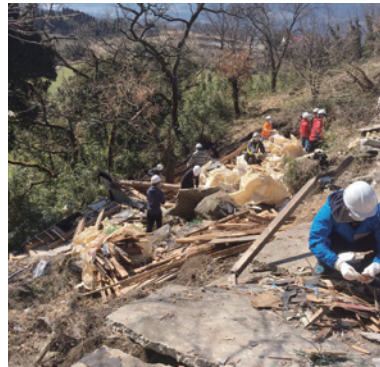
上／傾いた家屋を土砂で支える作業 左／解体された家屋の瓦礫撤去作業
